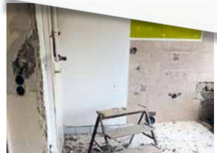
Die neuen Räumlichkeiten des Familienzentrums wurden vor der Übergabe umfassend saniert.
